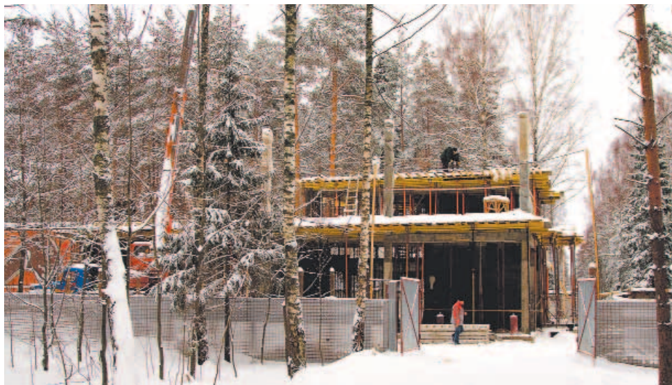
Строительные работы в конце декабря 2011 г.
